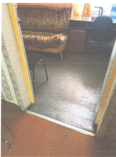
Фото № 14. Нанесение контрастных полос для полового покрытия и лестничных ступеней
