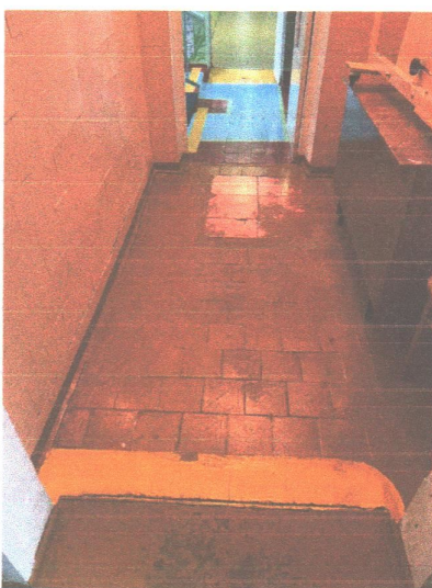
Фото № 13. Нанесение контрастных полос для полового покрытия и лестничных ступеней
