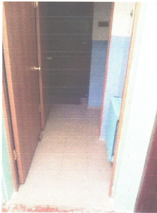
Фото № 10. Входной тамбур из 2-х секций
