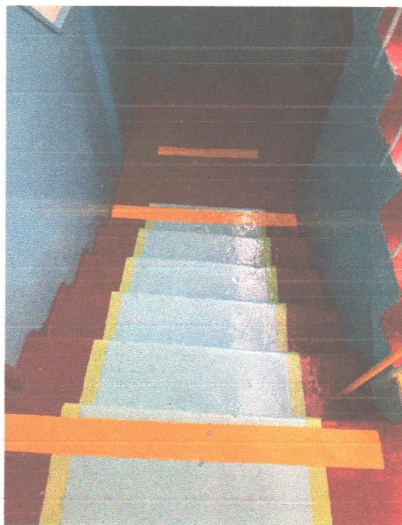
Фото № 11. Нанесение контрастных полос для полового покрытия и лестничных ступеней
