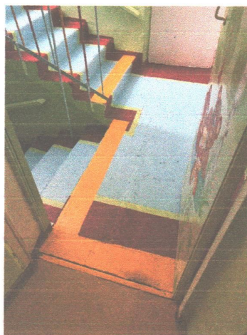
Фото № 15. Нанесение контрастных полос для полового покрытия и лестничных ступеней
