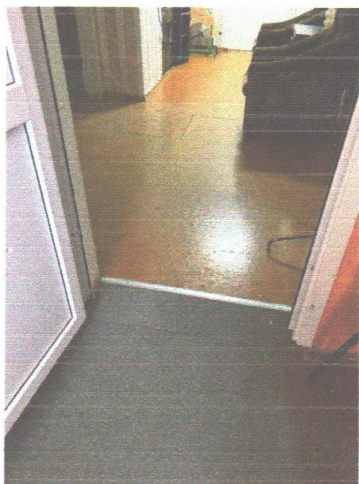
Фото № 12. Нанесение контрастных полос для полового покрытия и лестничных ступеней
