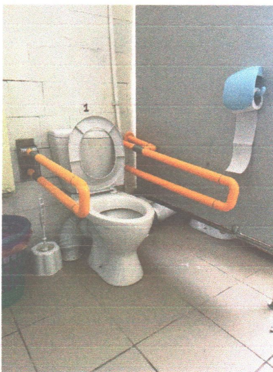
Фото № 20. Монтаж поручней в туалетной комнате
