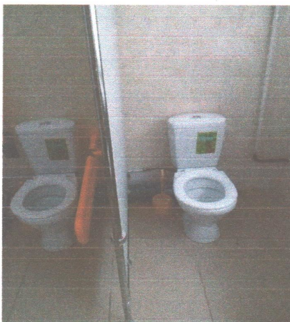
Фото № 21. Монтаж перегородок
