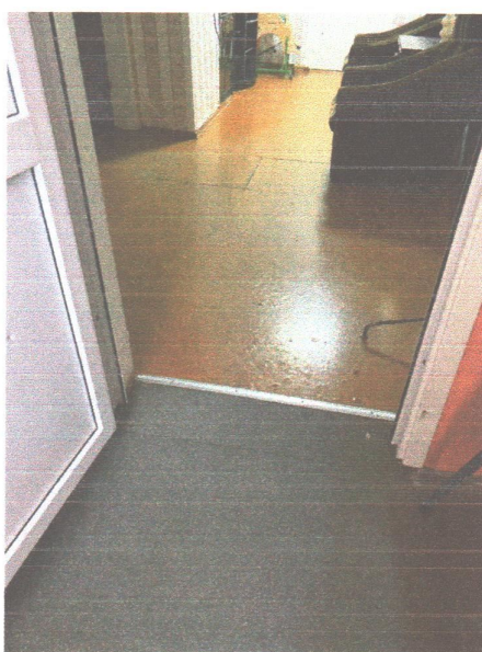
Фото № 16. Нанесение контрастных полос для полового покрытия и лестничных ступеней
