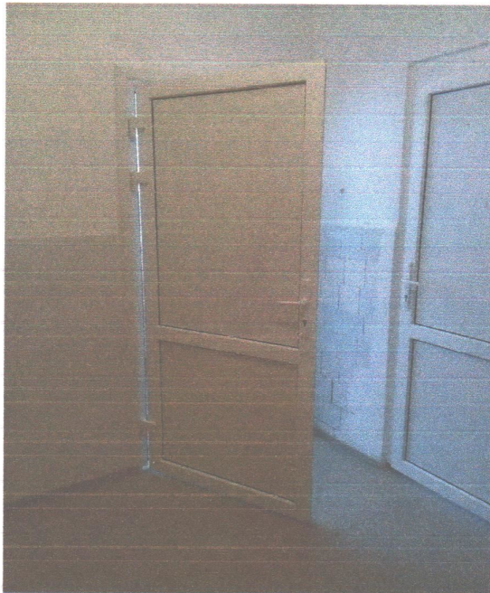
Фото № 25. Установлены двери без остекления
