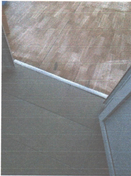
Фото № 24. Демонтаж порогов в ванной комнате
